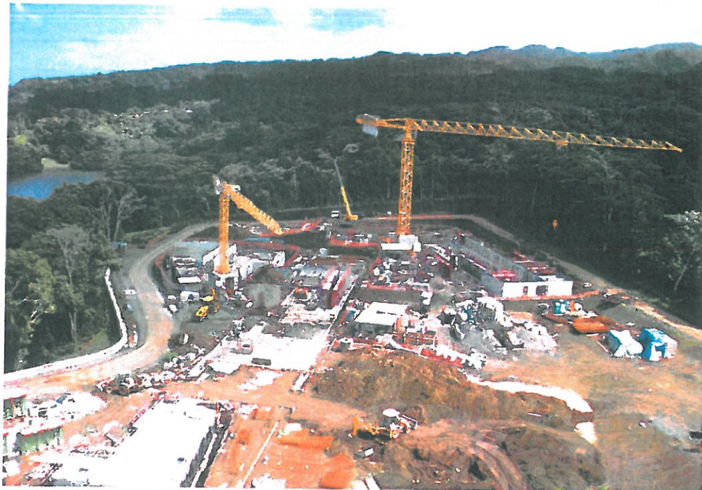
Vue aérienne du chantier durant la réalisation du gros oeuvre.
