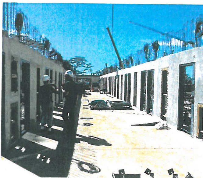
Après le gros œuvre, les finitions intérieures débuteront en 2015.
